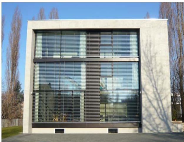
Bild 2. Fertiges Haus mit Infraleichtbetonaußenwänden
