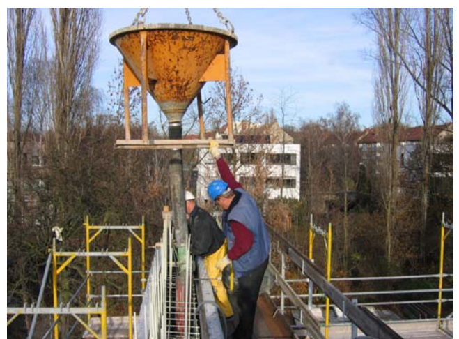
Bild 12. Ausbreitmaß und Einbringen mit Kübel
