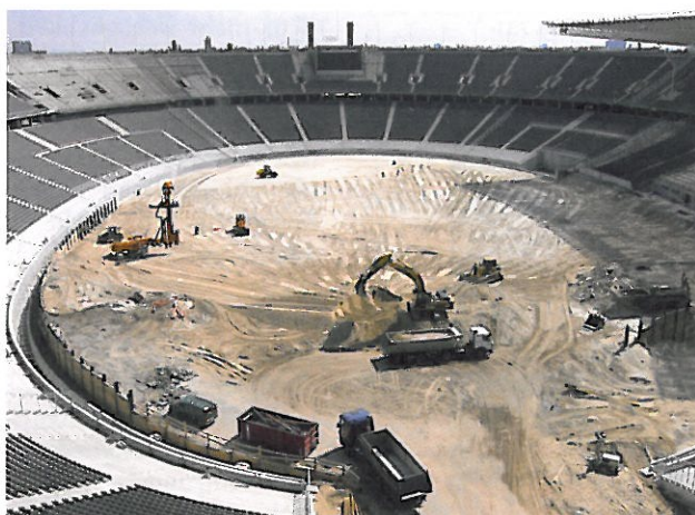
Abb. 4: ... unter Beteiligung der Berliner Betoninstandsetzungs-Firma von 2003 bis 2006.
