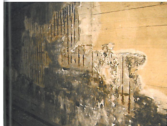
Abb. 2: Gegen Korrosion, für Wiederherstellung – mit Spritzbeton im Schichtdienst
