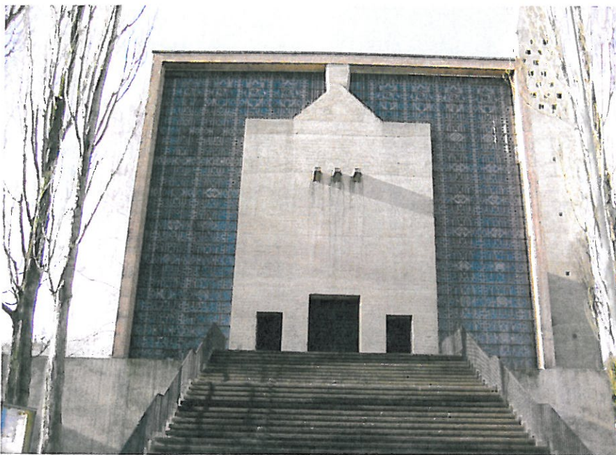
Das imposante Eingangsportal der denkmalgeschützten Fatima-Kirche
