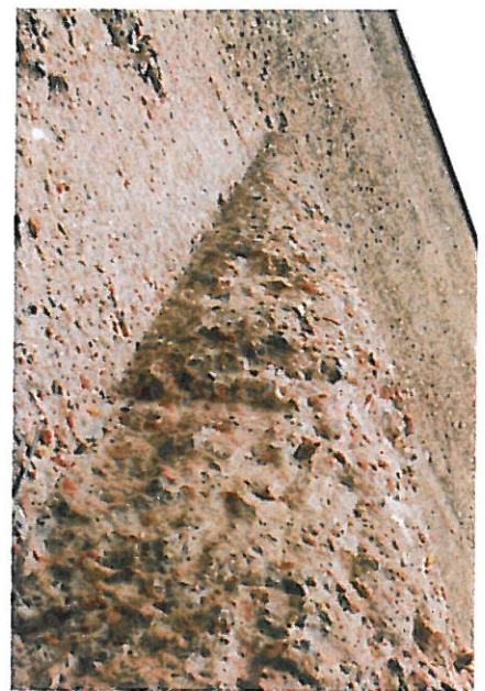
Abgestemmt Dachbereich der Konche; Bildunterschrift: Die Konchen vor der Einspritzung der speziellen Betonrezeptur
