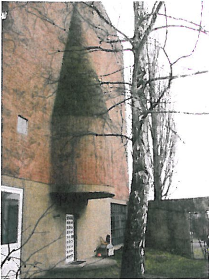
Die Konchen in fertig saniertem Zustand.
