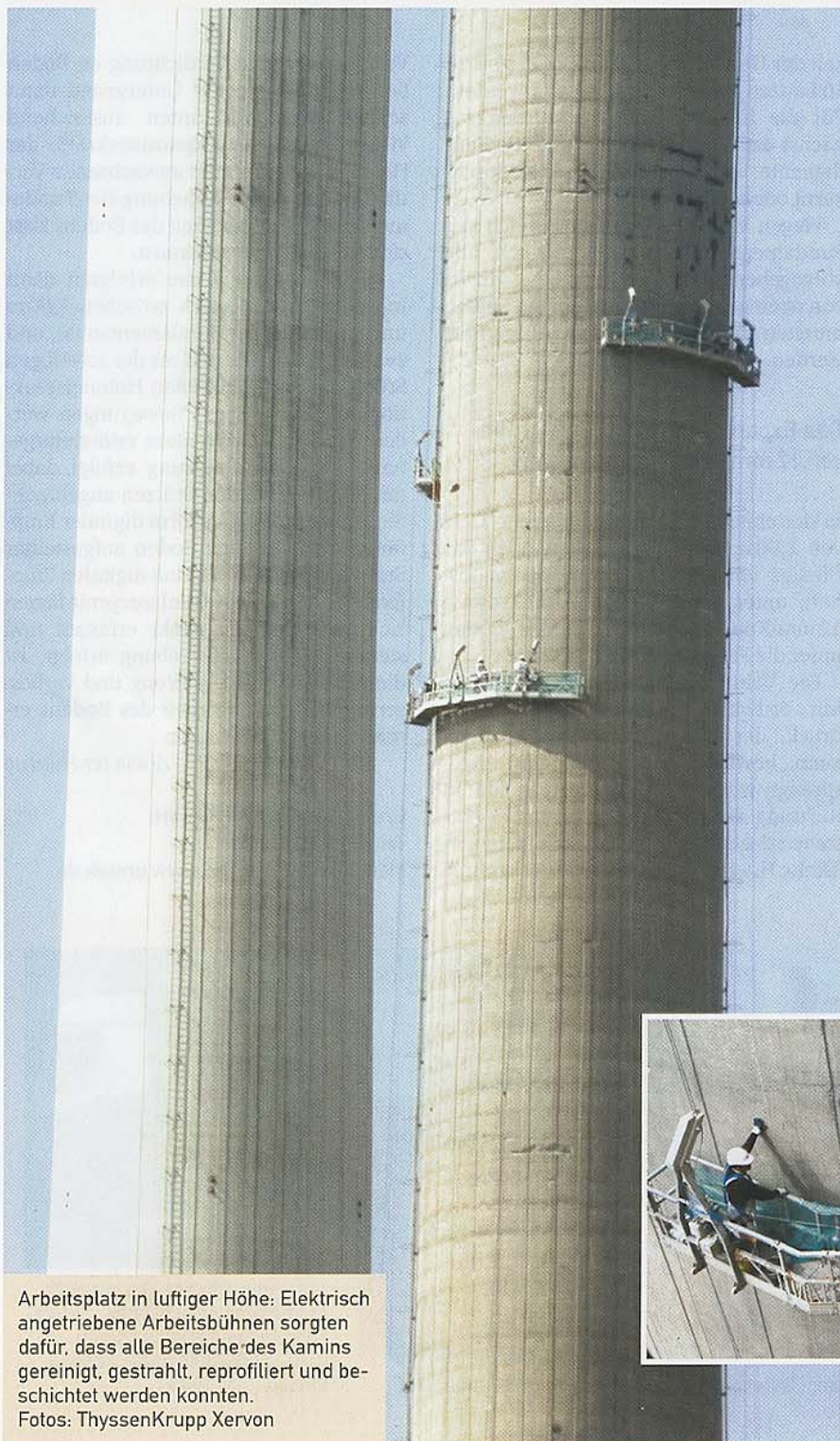
Mit Mann und Material bis in 240 m Höhe: Betonsanierung am Scholvenener Rauchgaskamin.
