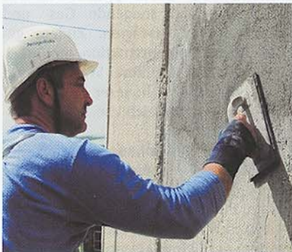
Sorgfältige Handarbeit: Von den Arbeitsbühnen aus wurde die schadhafte Beton-Außenhaut reprofiliert und gespachtelt.
