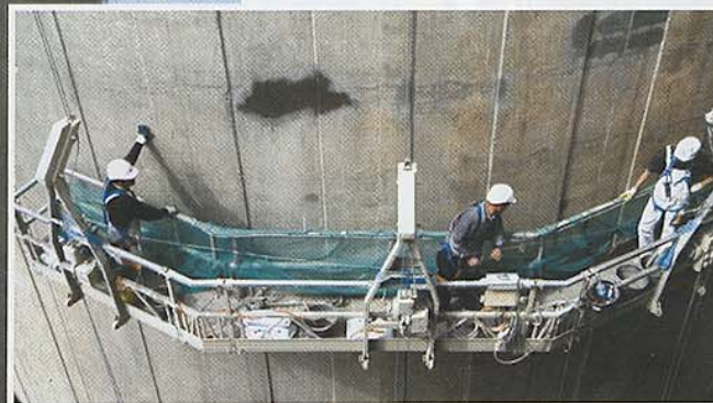
Mit Mann und Material bis in 240 m Höhe: Betonsanierung am Scholvenener Rauchgaskamin.
