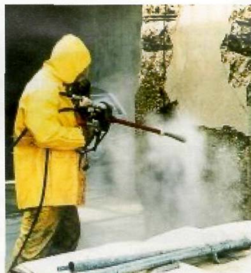
Bild 2. Untergrundvorbereitung durch Hochdruckwasserstrahlen
