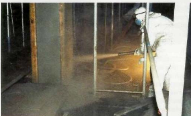
Bild 4. Instandsetzung durch Trockenspritzen
