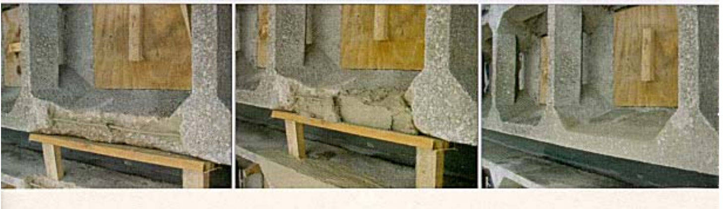
Wiederherstellung der originalen Betonoberflächen.
