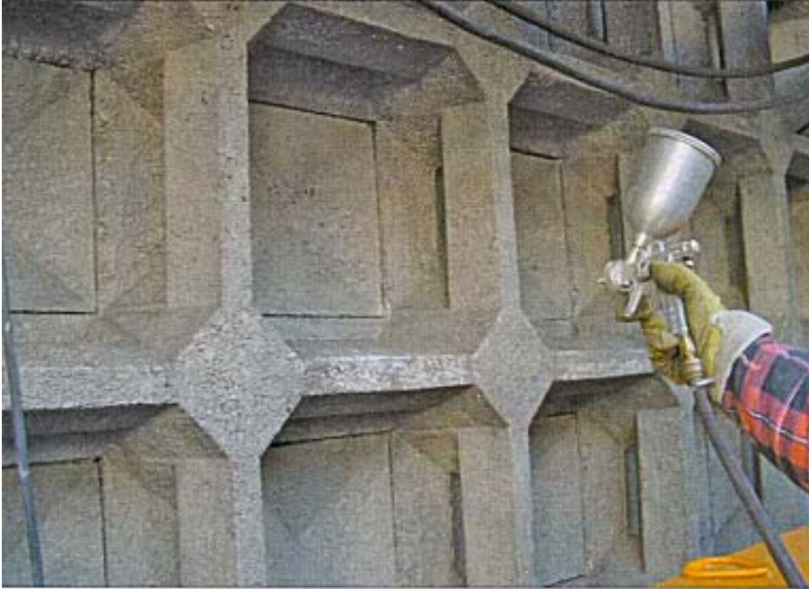
Durchführung von Oberflächenschutzmaßnahmen.
