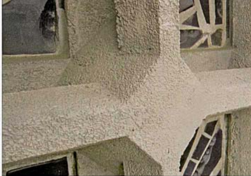
Waben nach Aufbringen des Oberflächenschutzes.
