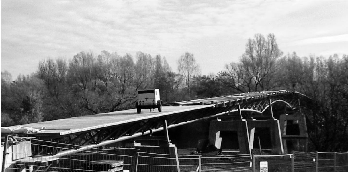
Bild 3: Blick auf die Gärtnerplatzbrücke in Kassel; Stand Frühjahr 2007. Deckenplatten und Obergurte aus UHPC, Raumfachwerk aus Stahlrohren.
