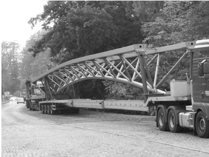
Bild 5: Mittelteil der Brücke mit ursprünglich gerade betonierte, erst bei der Montage an das Stahlfachwerk gebogenen Obergurten aus UHPC.
