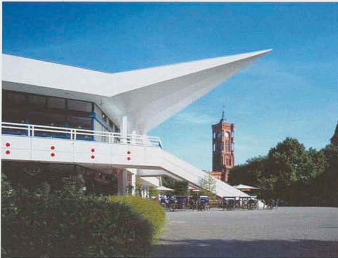
Bild 2. Betonbauwerke (hier: Fußbebauung des Fernsehturmes in Berlin) müssen geschützt, erhalten und, wenn nötig, fachgerecht instand gesetzt werden
