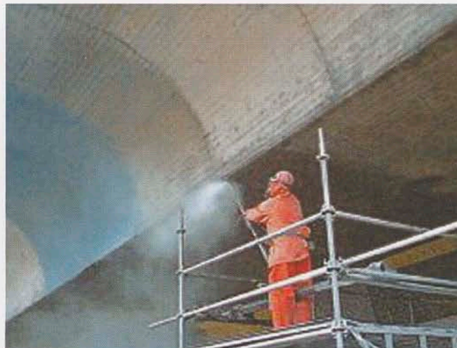
Bild 4. Die Sanierung von Bauwerken aus Stahlbeton hat sich in den letzten Jahren zu einem eigenständigen Arbeitsgebiet entwickelt und neue Verfahren und Produkte entstehen lassen (Fotos: Sto Cretec GmbH)
