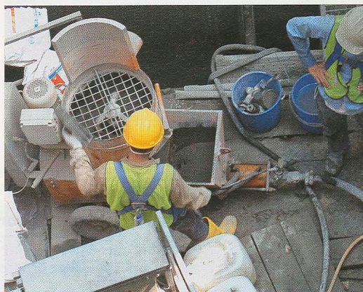
Wasserdampfdiffusionsoffenheit sichert den Dauerverbund von Schutzsystem mit dem Betonuntergrund
