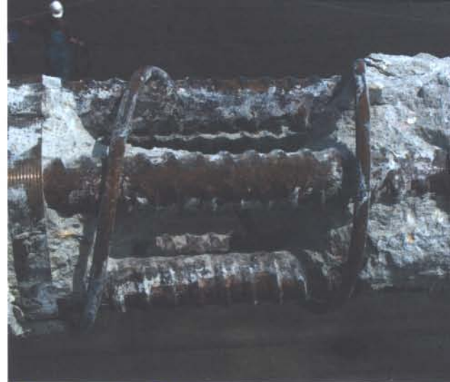
FREIGELEGTES ZUGBAND
