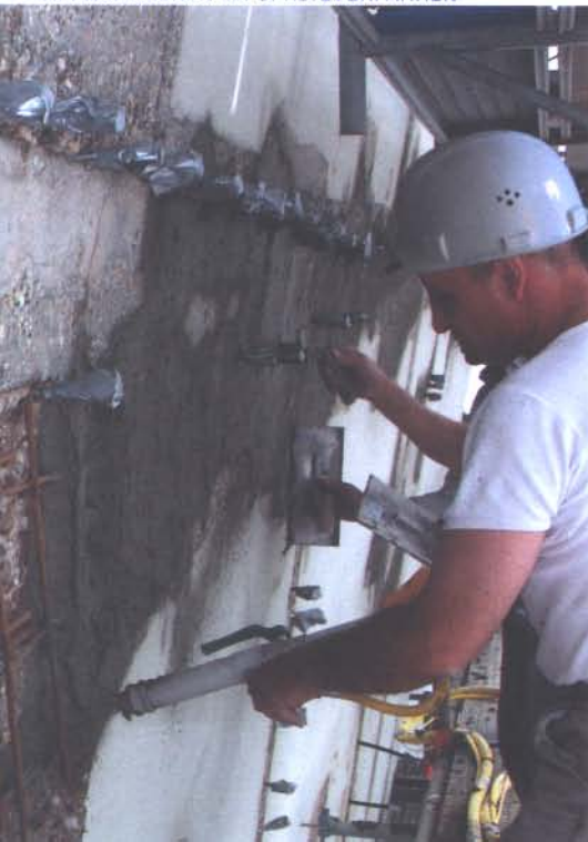
REPROFILIEREN IM SPRITZVERFAHREN
