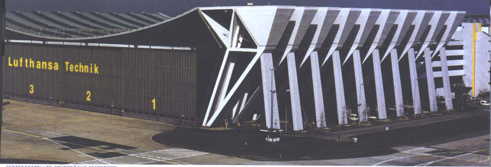
FERTIGGESTELLTE STÜTZBÖCKE (OSTSEITE)
