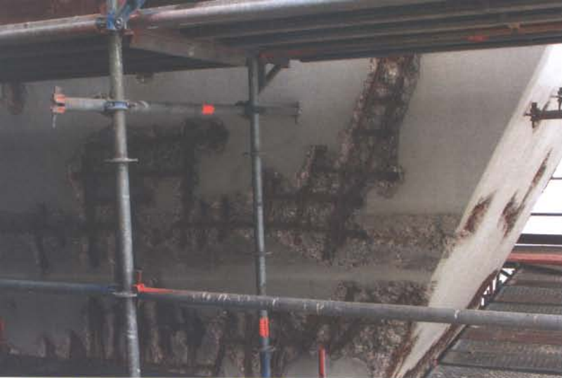
FREIGELEGTE BEWEHRUNG PASSIVIERT
