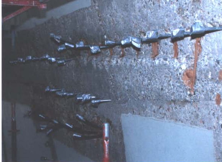
HOHLRAUM-RISSVERFÜLLUNG MIT ZEMENTLEIM UND ZEMENTLEIMSUSPENSION
