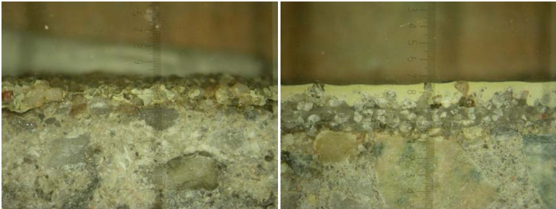
Bild 6: Vergleich einer starren abgestreuten Epoxidharzbeschichtung ohne Deckversiegelung (links: Alter 15 Jahre) und mit Deckversiegelung (rechts: Alter 10 Jahre); 1 Skalenteilung entspricht 0,1 mm
