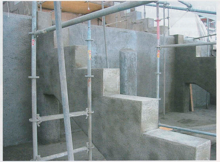
Wandscheiben und Zahnbalken der Tribünen nach Spritzbetonergänzung.
