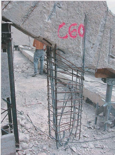
Teilweise sind Bauteile im Rahmen einer Betoninstandsetzung so stark geschädigt, dass sie unter Erhalt der Bestandsbewehrung komplett zurückgebaut und mittels mehrschichtigem Spritzbetonauftrag wieder hergestellt werden müssen.
