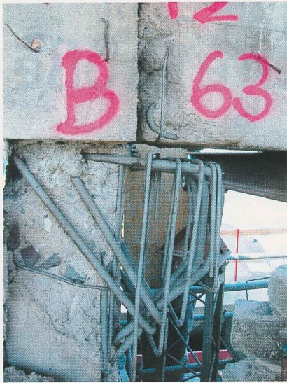
Stark beschädigte Bauteile, wie diese Bestandskonsole, werden unter Behalt der Bewehrung zurückgebaut, die vorhandene Bewehrung gesandstrahlt und ggf. ergänzt sowie mittels mehrschichtigem Spritzbetonauftrag wieder hergestellt.
