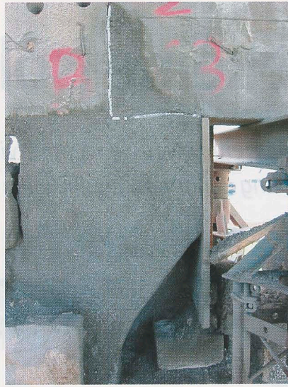
Stark beschädigte Bauteile, wie diese Bestandskonsole, werden unter Behalt der Bewehrung zurückgebaut, die vorhandene Bewehrung gesandstrahlt und ggf. ergänzt sowie mittels mehrschichtigem Spritzbetonauftrag wieder hergestellt.
