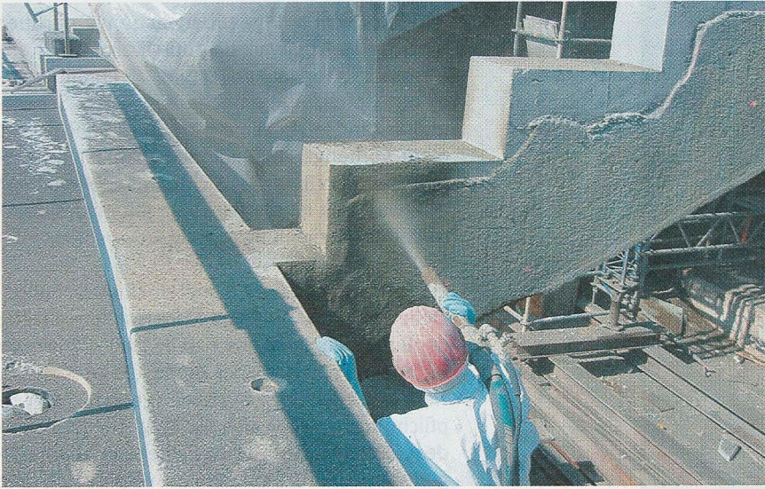
Sanierungsarbeiten am Olympiastadion
