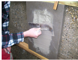
Reprofilieren 2. Lage Abbildung 1
