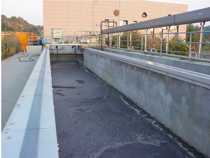
Abbildung 11: Sand- und Fettfang nach der Instandsetzung
